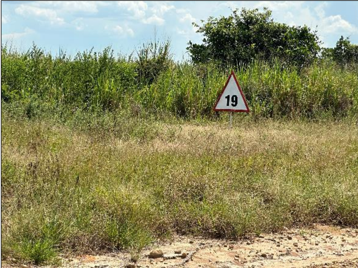
Figura 14: Indicador de umbral de pista 25 con numeración errónea.
