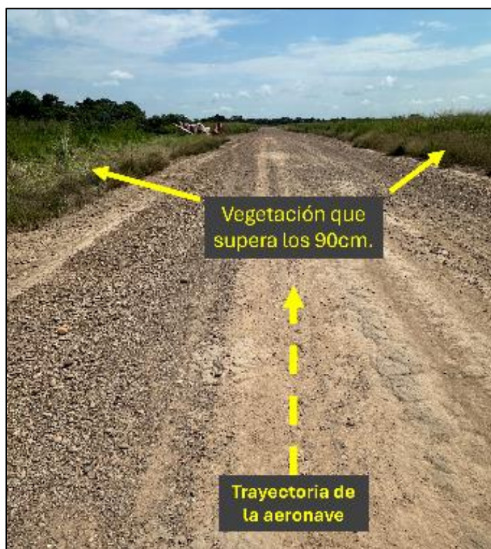
Figura 5: Vegetación densa en la franja de seguridad.
