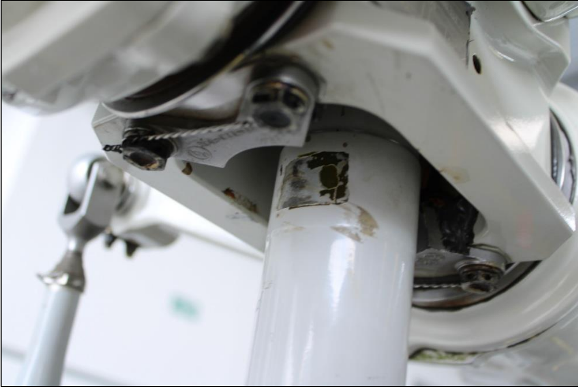
Imagen No. 7: Marcas de impacto en el mástil de potencia.
