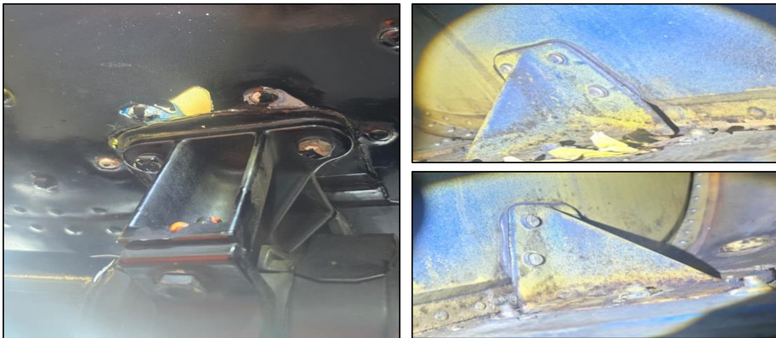
Imagen No. 6: Inspección tren de aterrizaje y de los soportes
