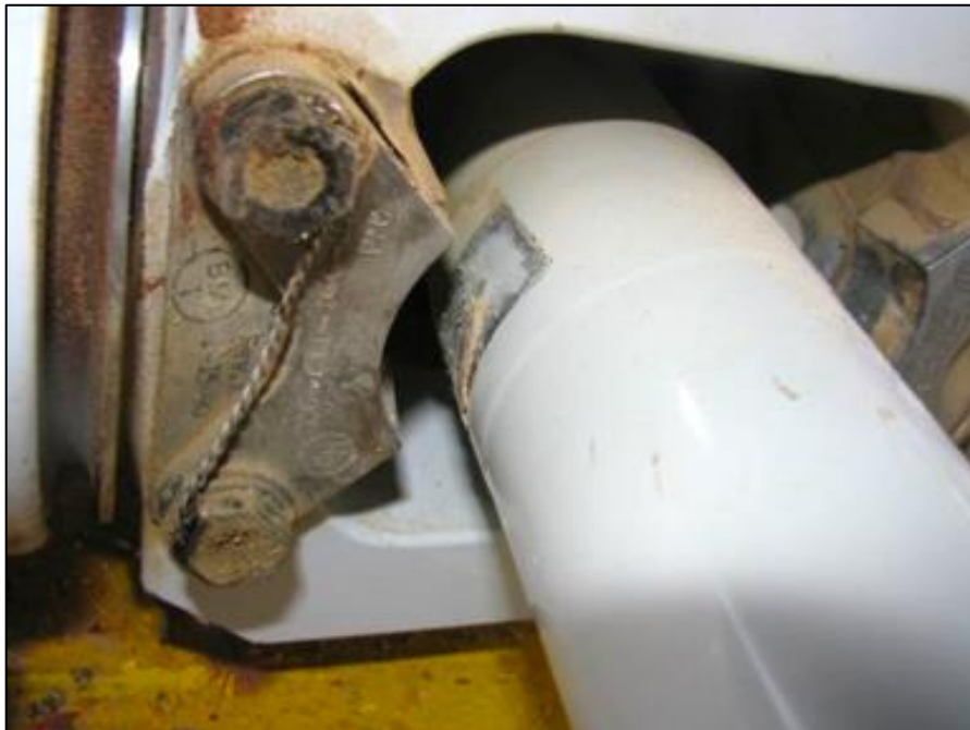
Fotografía No. 11 - Marca de contacto en el mástil debido al contacto fuerte por parada súbita en el impacto.
