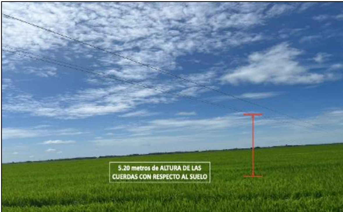
Fotografía No. 2: Cuerdas eléctricas a baja altura.
